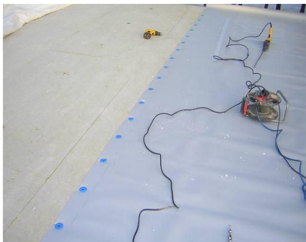
Рекомендуемое крепление и деформационные швы ОСП-плит:
