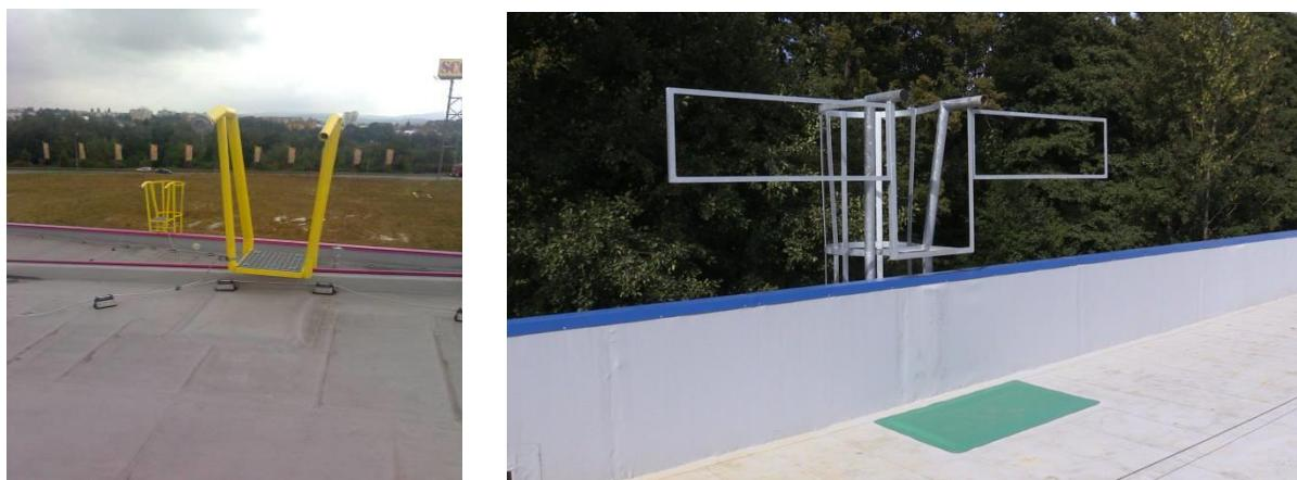
V místech předpokládaného zvýšeného mechanického namáhání střešní povlakové hydroizolace je vhodné hydroizolační fólie zajistit proti poškození například ochrannou vrstvou, zdvojením fólie, podložením tuhým plošným materiélem apod. Tato opatření většinou zvyšují odolnost střešního pláště i při vnějším působení požáru ([Detail 214S](#)).
