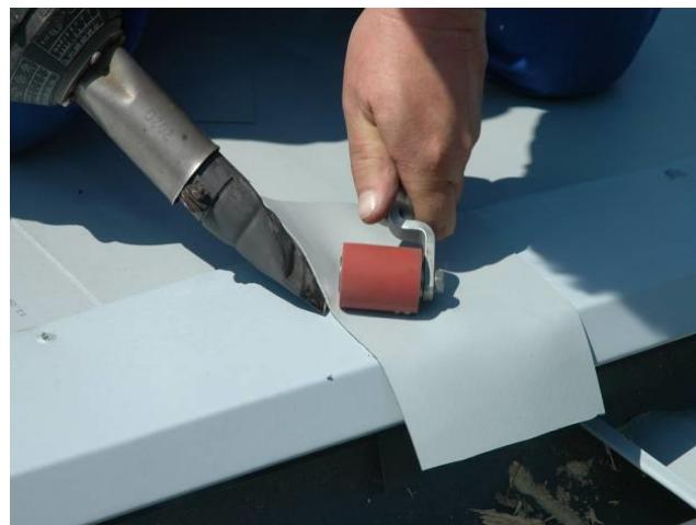
Obvodové klempířské prvky se obvykle připevňují přímo k podkladu (bez příponek). Kotvení se provádí navrženým nebo doporučeným typem kotev. Vzdálenost kotev nesmí být větší než 250 mm (9 ks / 2 m segment). Při větší šíři úchytných prvků je účelné provádět kotvení střídavě ve dvou liniích. Kotvicí prvky musí vždy zasahovat až do staticky stabilní vrstvy střešního pláště (beton, zdivo, dřevo, trapézový plech apod.).
