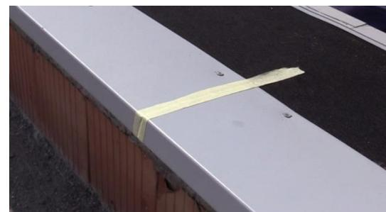
Spoje obvodových úchytných prvků se s výjimkou vnitřních a vnějších koutových lišť přeplátuji páskem homogenní fólie šířky cca 80-100 mm. Pásek homogenní fólie se navařuje pouze po svém obvodu svarem šíře 30 mm, čímž vznikne cca 20 mm široká deformační zóna bez navařené homogenní fólie. Za tímto účelem je výhodné před navařením homogenní fólie přelepit spoj plechů 20 mm širokou krepovou (malířskou) páskou.
