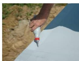
**POZOR!** Pojistná zálivka není opravným prostředkem pro nedokonalé svary, její funkce je především vizuální, umožňující po předcházející kontrole viditelně odlišit zkонтrolované spoje od nezkontrolovaných. Při řádném provedení svaru je spoj fólií stejně účinný a funkční i bez zálivky.
