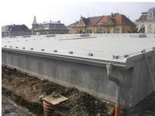
Ukončení hydroizolačního povlaku na svislé stěně je možno řešit buď přímo na konstrukčním zdivu s následným omítnutím plochy nad ukončením hydroizolační vrstvy nebo na povrchu již provedené omítky se zatmelením trvale pružným tmelem. Při tomto způsobu ukončení je třeba zohlednit možnost prosáknutí stékající vody konstrukcí stěny. Výška horního okraje ukončení fólie nad úrovni povlakové hydroizolace přilehlé plochy musí být nejméně 150 mm ([Detail 303S, 304S, 305S](#)).
