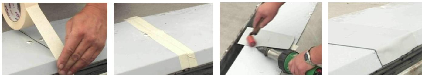
U střechy přitížené stabilizační, provozní nebo ochrannou vrstvou z volně uloženého kameniva či střechy s pěstebním souvrstvím se na okapnici z poplastovaného plechu připevňuje hliníková nebo nerezová kačírková lišta. Příklad opracování okapu zateplené střechy se zásypem schematicky znázorňuje [Detail 504S](#).
