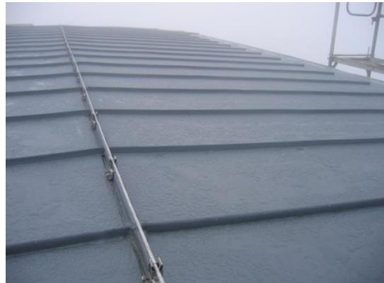
Profil Novoplast druh 1871 se pokládá vždy po spádu nebo šikmo po spádu, aby byl zajištěn odtok srážkové vody z povrchu povlakové hydroizolace. Přivařený profil plní pouze funkci pohledovou, není určen a nesmí být nikdy použit pro spojování dvou pásů fólie!
