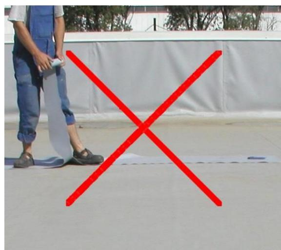
Po položení pásu do požadované polohy se fólie podle kotevního plánu mechanicky kotví příslušným množstvím navrženého typu kotev pro jednotlivé oblasti střechy.
