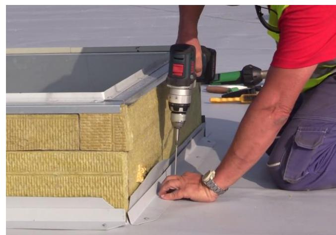
Užitné vlastnosti poplastovaného plechu jsou dány především použitím kvalitního plechu, vhodného pro aplikace ve stavebnictví a složením PVC vrstvy zaručujícím vysokou UV odolnost a odolnost proti tepelné degradaci při svařování horkým vzduchem. Plechy FATRANYL nevyžadují po celou dobu životnosti žádnou údržbu či obnovu PVC vrstvy.
