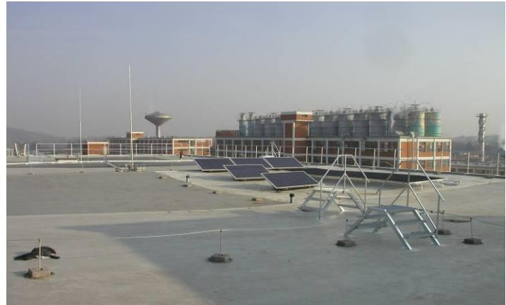
Hromosvodná zařízení umístěná na střešním plášti v pochozích trasách nesmí vytvářet překážky a k jejich překonání je nutné zřídit bezpečné přechody.
