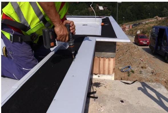
Doporučený sklon koruny atiky je min. 3° (cca 5 %) dovnitř objektu. Přesazení obvodových úchytných prvků přes vnější líc přiléhající svislé konstrukce je min. 30 mm (ČSN 73 3610). K obvodovým úchytným prvkům z poplastovaného plechu se fólie FATRAFOL přivařují horkým vzduchem s min. šírkou svaru 30 mm ([Detail 501S, 503S](#)).
