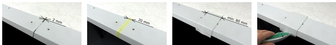
U vnitřních a vnějších koutových lišť se převaření homogenní fólií neprovádí, doporučuje se ale vynechat svar v délce cca 50 mm v dilatačním spoji plechu. Výhodné je přelepení spoje plechů krepovou páskou doporučené šířky 50 mm.
