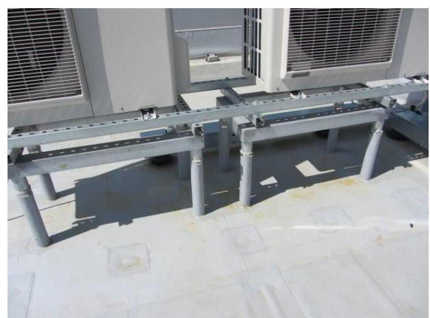
Horní okraj svislé části tvarovky nebo přířezu z homogenní fólie se zajistí nekorodující páskou s podtmelením fólie na prostupu trvale pružným PU tmelem ([Detail 606S, 608S](#)).
