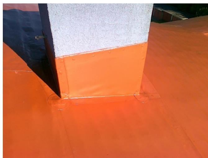
Technologická potrubí s teplotou povrchu vyšší než 40 °C musí být v místě napojení hydroizolačního povlaku opatřena chráničkou s tepelnou izolací min. do úrovni horního okraje hydroizolačního povlaku. Spára mezi horním okrajem povlaku a prostupující konstrukcí se zatmelí trvale pružným tmellem odolávajícím dané provozní teplotě povrchu a opatří objímkou nebo klempířským kloboučkem s vodotěsným napojením a prostupující prvek ([Detail 607aS, 607bS](#)).
