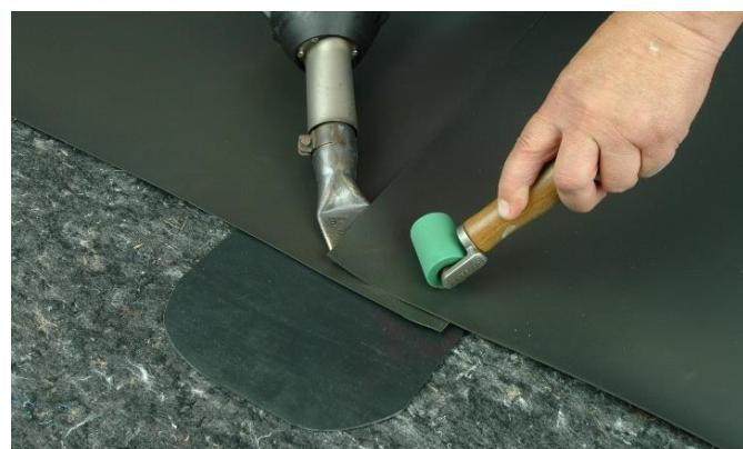
Tato technologie umožňuje při dodržení správného pracovního postupu dosáhnout pevnosti spoje ve smyku odpovídající nejméně 80 % výrobcem deklarované pevnosti použité hydroizolační fólie. Svařování se provádí v přesazích pásů min. 50 mm. Při použití ručního svařovacího přístroje musí být šířka svaru min. **30 mm**. Většina automatických svařovacích zařízení disponuje svařovací hubicí šíře 40 mm.
