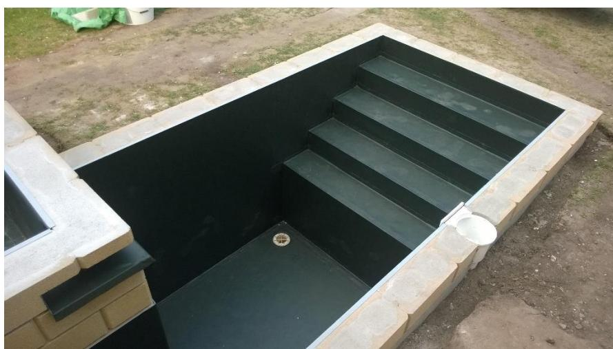
Obvodové klempířské prvky se obvykle připevňují přímo k podkladu. Kotvení se provádí navrženým nebo doporučeným typem kotev. Vzdálenost kotev by neměla být větší než 250 mm (spotřeba 4,5 ks/m délky). Kotvicí prvky musí vždy zasahovat až do staticky stabilní vrstvy nosné konstrukce (beton, zdivo, apod.).
