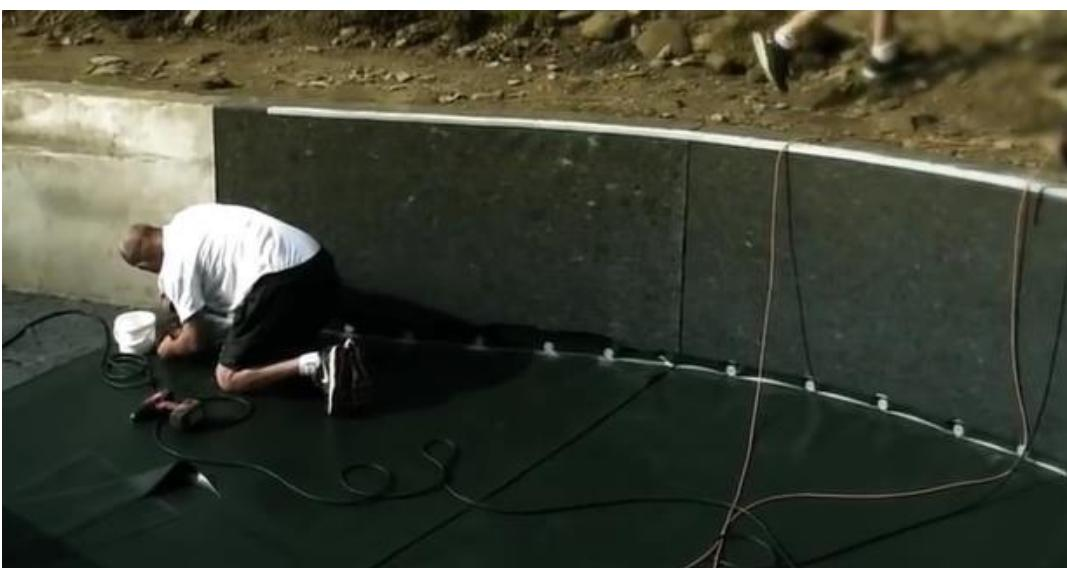
V případě kotvení do železobetonu se obvykle provádí předvrtání otvoru o průměru 5,0 až 5,5 mm dle doporučení jednotlivých výrobců, kteří současně uvádí i doporučené hloubky zavrtání.
