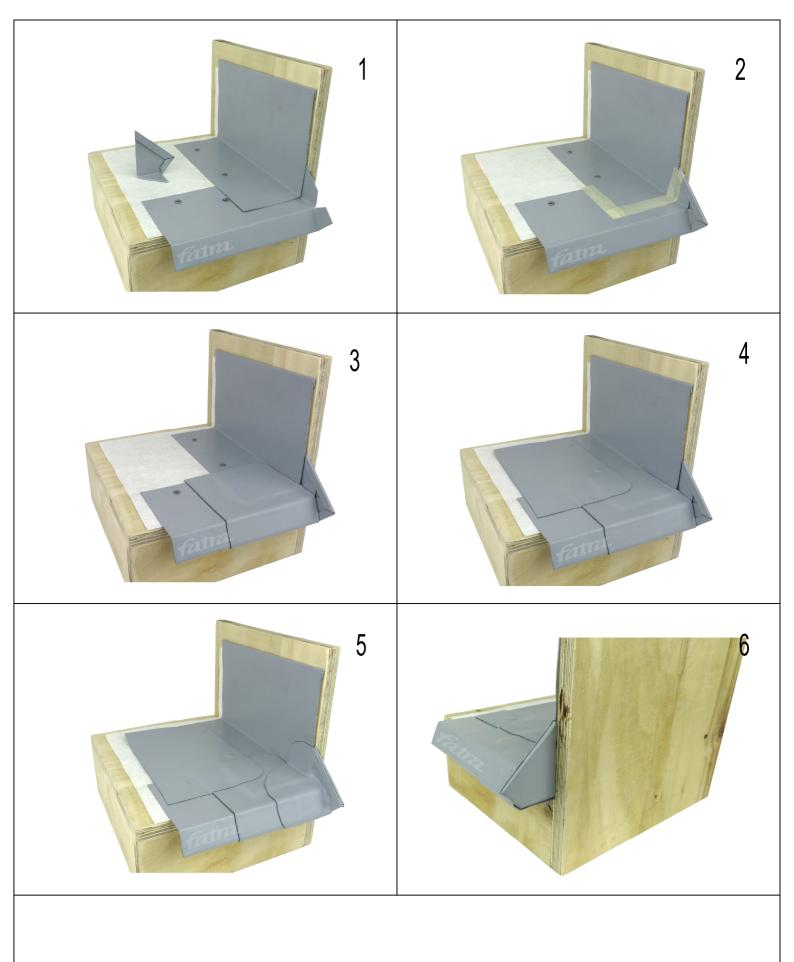
ПЕРЕХОД С ГОРИЗОНТАЛИ НА ВЕРТИКАЛЬ, ВНУТРЕННИЙ УГОЛ БАЛКОНА И КАПЕЛЬНИК ИЗ ПВХ МЕТАЛЛА
