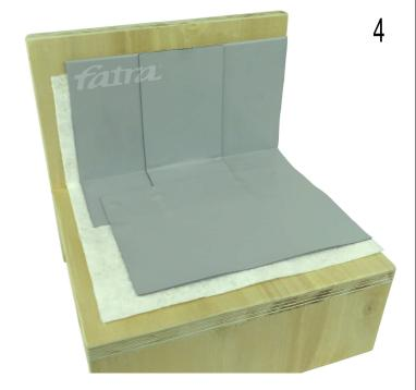
СТЫК БОЛЬШИХ L ПРОФИЛЕЙ ИЗ ПВХ МЕТАЛЛА ПРИ ПЕРЕХОДЕ С ГОРИЗОНТАЛИ НА ВЕРТИКАЛЬ
