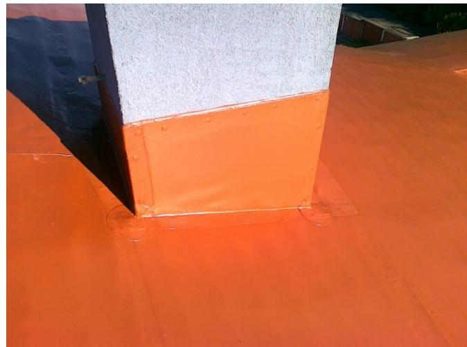
Технологические трубы с теплотой поверхности выше 40 °C должны быть в месте соединения с гидроизоляционным покрытием оснащены предохранительной трубкой из теплоизоляции мин. до уровня верхнего края гидроизоляционного покрытия. Зазор между верхним краем покрытия и выступающей конструкцией обрабатывается эластичным герметиком, устойчивым к данной эксплуатационной температуре поверхности и оснащается муфтой или заглушкой с герметичным присоединением к выступающему элементу ([Деталь 607S](#)).
