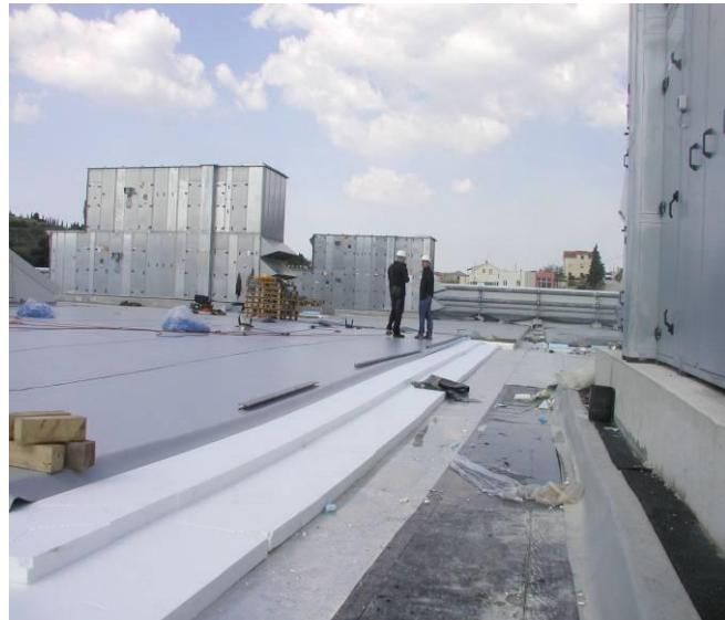
Создание деформационных швов в бетонной стяжке, которая является основанием для крепления, проводится в соответствии с нормой ČSN 731901.
