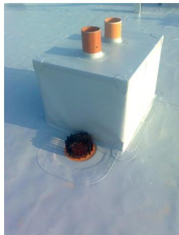
Примыкание мембранный изоляции к вертикальной поверхности можно обработать в соответствии с п. 5.2.6.1 планкой примыкания; или изоляция должна быть герметично присоединена к выступающему корпусу водонепроницаемым материалом; при пропуске деталей из твердого ПВХ мембрана приваривается к покрытию выступающего корпуса; материалы, не сваривающихся с ПВХ или ТПО обрабатываются полиуретановым герметиком и т.п.
