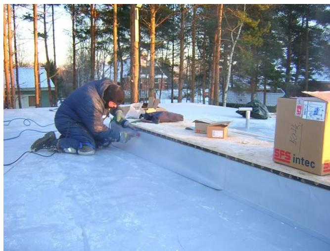
Монтажники могут ходить по уложенной гидроизоляционной мемbrane только в обуви с мягкой подошвой, которая исключает механическое повреждение мембраны и обеспечивает при этом безопасное хождение по мембране без риска поскользнуться, в то же время соответствует требованиям к безопасности средств индивидуальной защиты.
