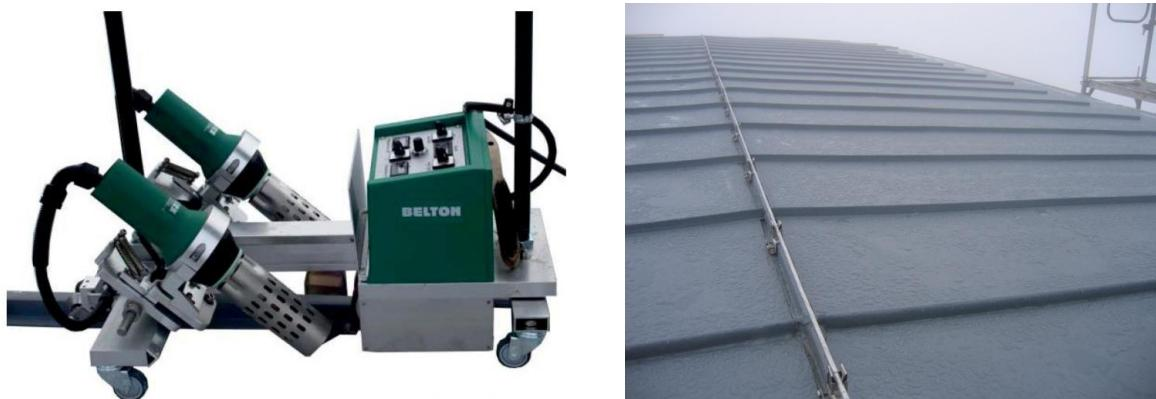
Профиль Novoplast тип 1871 укладывают всегда в направлении уклона или наискосок по отношению к уклону, чтобы обеспечить отвод дождевых вод с поверхности кровельного покрытия. Приваренный профиль выполняет только декоративную функцию, он не предназначен и не может быть использован для соединения двух полос мембранны!
