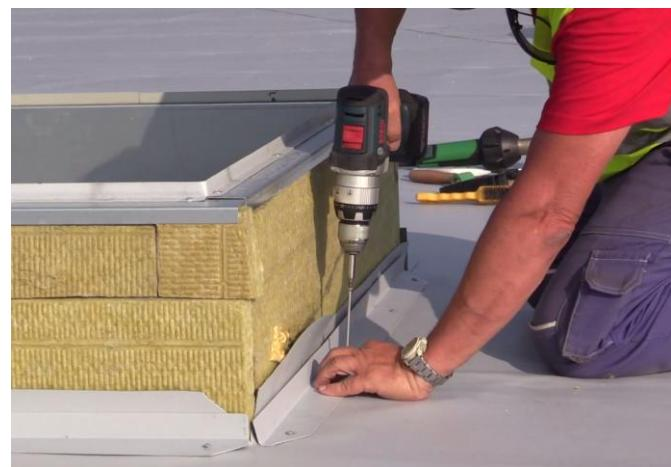
Потребительские свойства металлопласта зависят, прежде всего, от качества использованной жести, пригодной для использования в строительстве, а также от состава ПВХ слоя, обеспечивающего высокую стойкость к ультрафиолетовому излучению и устойчивость к термическому разложению во время сварки горячим воздухом. Для FATRANYL не требуется обслуживание или обновление ПВХ слоя на протяжении всего срока службы.
