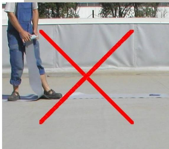
После укладки полосы в желаемое положение мембрану в соответствии с планом крепления механически закрепляют соответствующим количеством крепежей, предусмотренного проектом типа для отдельных зон крыши.
