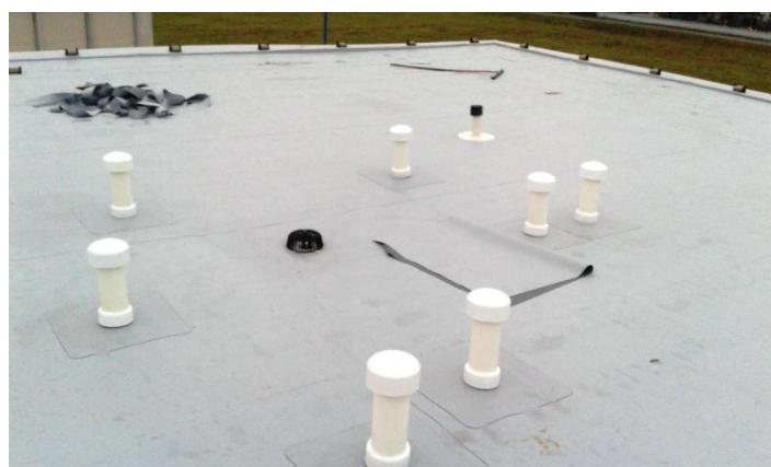
Вентиляционные выходы по всей поверхности привариваются к мемbrane, нет необходимости дополнительно из закреплять.
