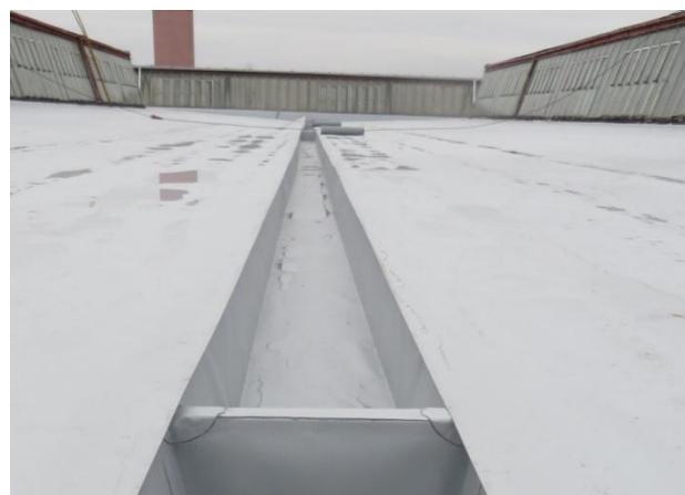
Способ обработки водосборных лотков, парапетных желобов и ендов зависит от их формы и размера.
