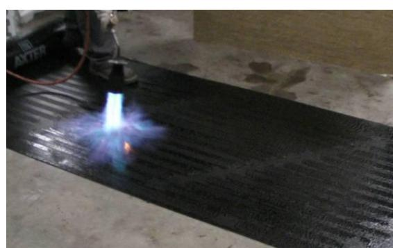
**Назначение:** Полосы паронепроницаемого покрытия пригодны для наплавления на все виды поверхностей.
