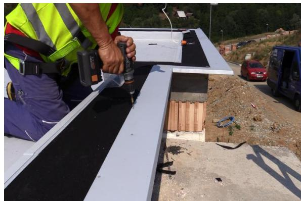
Рекомендуемый уклон верхней поверхности парапета внутрь объекта должен быть мин. 3° (прибл. 5 %). Перекрытие краевых прижимных элементов через наружную лицевую поверхность вертикальной конструкции мин. 30 мм (ČSN 73 3610). Мембрана FATRAFOL приваривается к краевым прижимным элементам из металлопласти горячим воздухом, ширина шва мин. 30 мм ([Деталь 501S](#), [Деталь 502S](#)).
