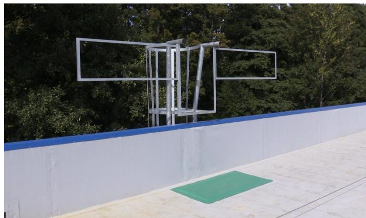
В местах предполагаемой повышенной механической нагрузки на кровельное покрытие необходимо защитить гидроизоляционную мембрану от повреждения, напр. защитным слоем, укладкой мембранны в два слоя, укладкой под мембрану жесткого сплошного материала т.п. Эти меры обычно помогают повысить устойчивость кровельного ковра и к воздействию внешнего пламени.
