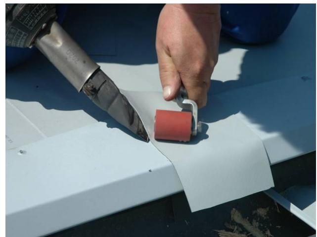
Краевые доборные элементы из жести обычно крепятся прямо к основанию (без костылей). Крепление производится крепежами согласно проекту или рекомендациям. Расстояние между крепежами не должно быть более 250 мм (мин. частота крепления в длину 4 шт./м). Широкие прижимные элементы более эффективно крепить двумя рядами крепежей, размещая их в шахматном порядке. Крепежные элементы всегда должны доставлять до статически стабильного слоя ковра (бетон, кладка, дерево, профилированный лист и т.д.).
