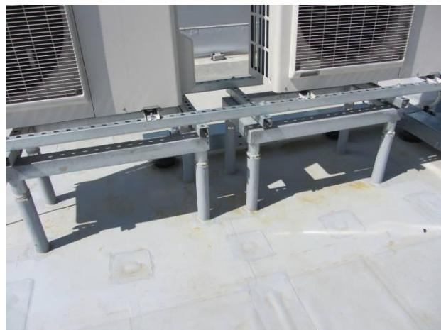
Верхний край вертикальной части фасонного элемента или заготовки из гомогенной мембранны закрепляется некорродирующей лентой и обрабатывается эластичным полиуретановым герметиком ([Деталь 605S](#), [Деталь 608S](#)).
