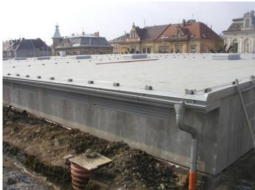
Примыкание покрытия осуществляется с помощью системных профилированных краевых прижимных элементов из металлопласта (Деталь 208S, 301S, 302S, 303S, 501S – 507S). При соединении мембранны с этими элементами из металлопласта действуют те же принципы, как и при соединении мембран в плоскости крыши.
